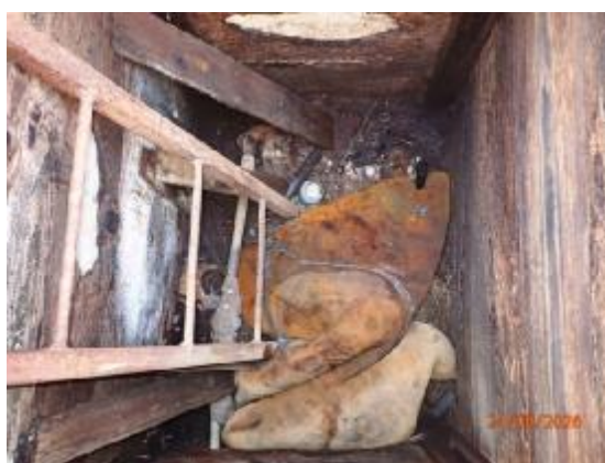
Pohľad do vodomernej šachty pred stavbou
