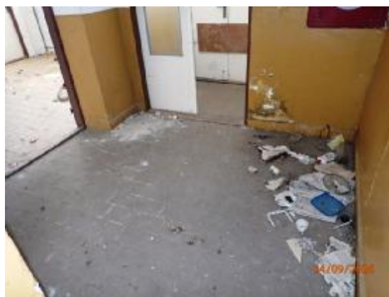
Chodba 236 na I.NP
