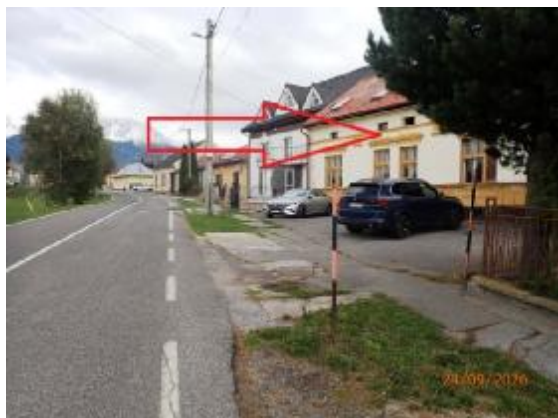
Hlavná ulica pred stavbou v smere na SZ
