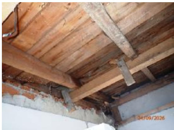
Detail časti krovu na II.NP
