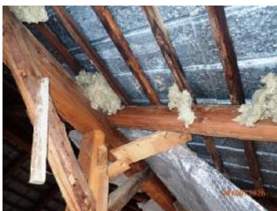
Detail časti krovu na II.NP
