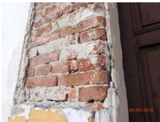
Detail pôvodného muriva stavby
