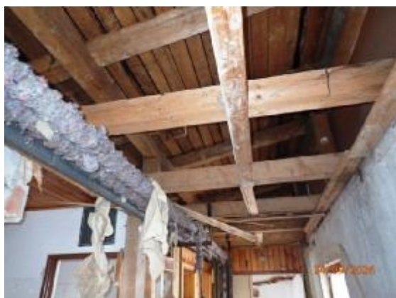
Detail časti krovu na II.NP
