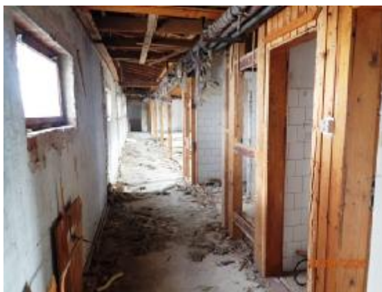
Chodba priestoru 307 na II.NP
