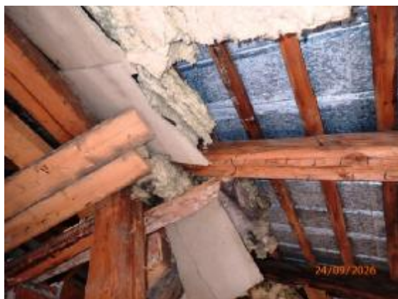
Detail časti krovu na II.NP
