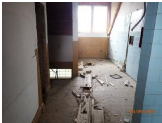
Schodisko 317 na II.NP
