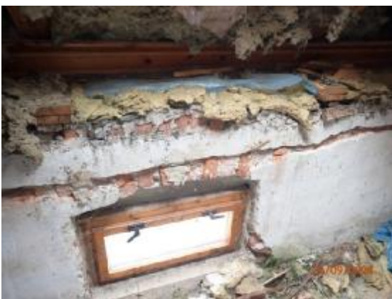
Okno od ulice na II.NP v priestore 308
