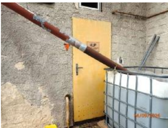
Vstup do plynomerne 228 z dvora na I.NP
