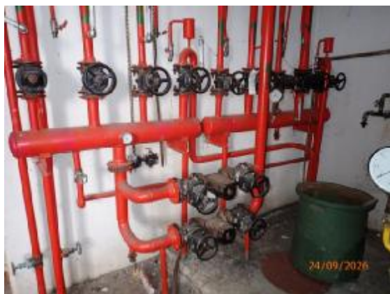
Rozdeľovač v kotolni
