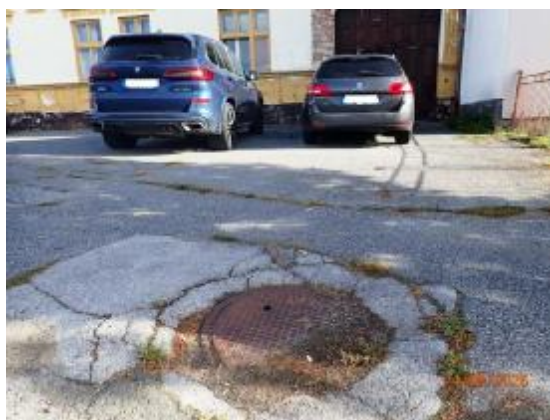
Kanalizačná šachta pred stavbou
