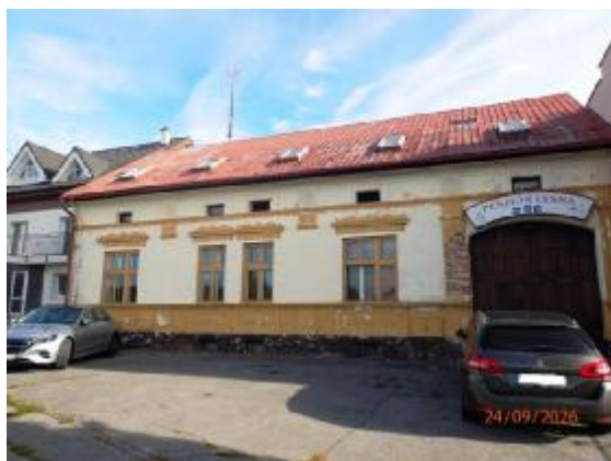
Pohľad na stavbu z ulice
