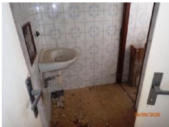
Chodba 231 na I.NP
