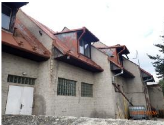
Pohľad na stavbu zo záhrady
