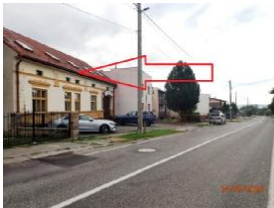
Hlavná ulica pred stavbou v smere na JV
