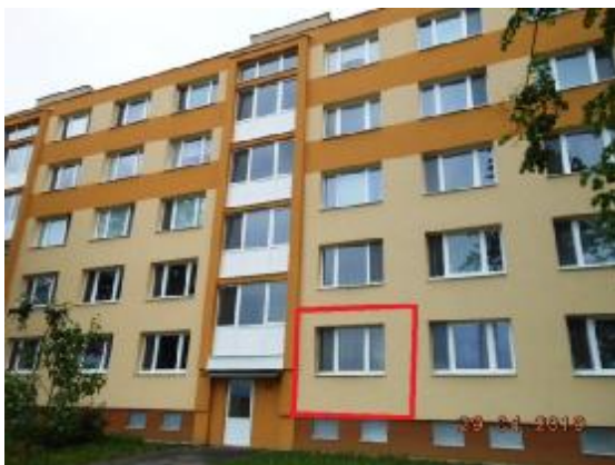
Pohľad na bytový dom z východnej strany
