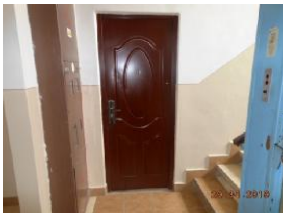
Vchod do ohodnocovaného bytu č. 9
