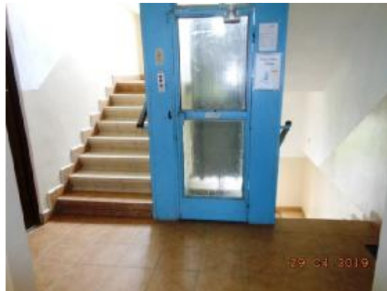
Chodba, schodisko a výťah na prízemí domu
