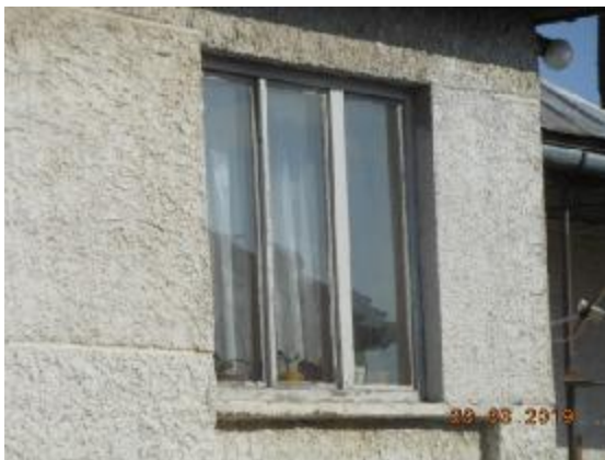
Pôvodné okno z dvora
