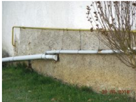
Nevhodné riešenie kanalizácie za domom
